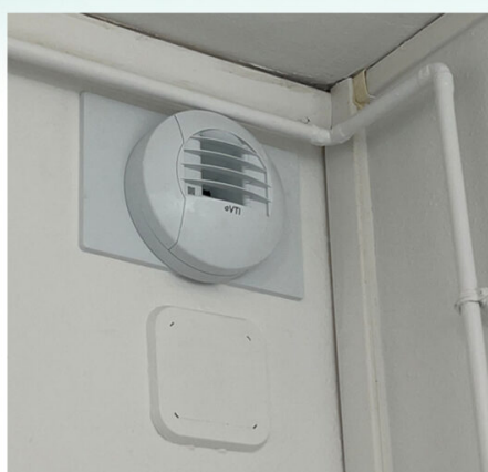
Marché de réhabilitation de la ventilation pour Seqens, modernisation du système de ventilation sur 98 logements à Villeneuve-la-Garenne, avec remplacement des équipements VMC pour améliorer la qualité de l'air intérieur en milieu occupé.
