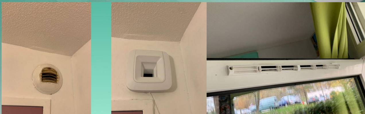
Marché de réhabilitation de la ventilation pour Toit et Joie Habitat, remplacement des bouches d'extraction et installation d'entrées d'air neuves dans les logements, avec ramonage des conduits et ajustement des portes pour optimiser la circulation de l'air à Maurepas.
