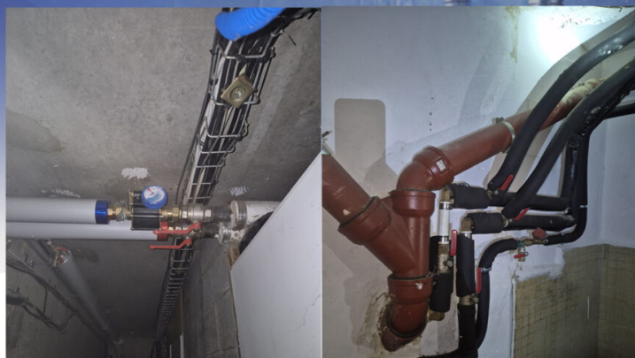
Marché de la réhabilitation en plomberie pour Seqens, remplacement complet des nappes horizontales ECS en sous-sol de la Résidence Massy Dauphiné, avec reprise des tuyauteries aux pieds de colonnes, équilibrage du réseau et désinfection avant mise en service.
