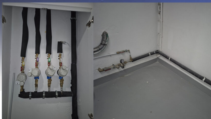
Marché de réhabilitation en plomberie pour Immobilière 3F à Chennevières-sur-Marne, 282 logements création d'un réseau PER avec compteurs individuels, vannes de sectionnement et calorifugeage complet.
