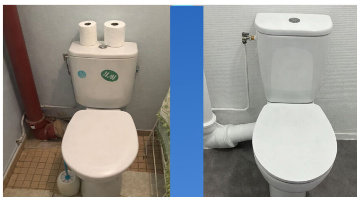
Marché de réhabilitation des sanitaires pour Valophis Habitat, réhabilitation complète de 356 logements à Villeneuve-Saint-Georges, incluant le remplacement des équipements sanitaires, la réfection des salles de bains, la rénovation des sols et la remise en peinture des murs et plafonds.
