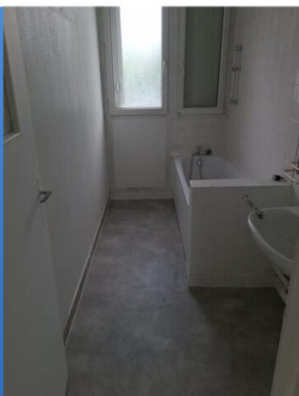
Marché d'entretien courant REL (Remise en état de logement) pour Seqens, remplacement du sol par un sol souple et reprise de la faïence. Dépose du revêtement dégradé et pose d'un sol vinyle adapté aux pièces humides, avec reprise localisée des carreaux de faïence décollés en plinthe et paroi.
