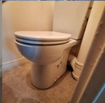
Marché d'entretien courant pour Valdevy, pose d'un WC surélevé avec pipe, fixations, flexible 12x17 et abattant ralenti. Remplacement du WC par un modèle surélevé adapté PMR avec pipe d'évacuation sur mesure, fixation au sol et raccordement 12x17 abattant à fermeture ralentie posé en finition.
