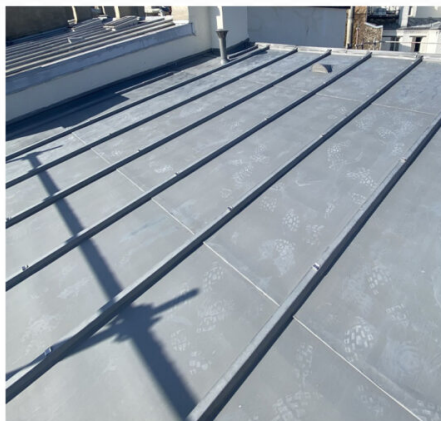
Marché de couverture pour Immobilière 3F, réfection de la couverture et de la verrière du 72 avenue des Gobelins à Paris 13e, avec traitement de l'étanchéité, amélioration de l'isolation en toiture et sécurisation.
