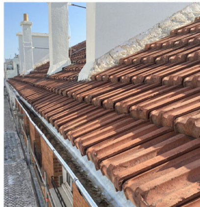
Marché de couverture pour 1001 Vies Habitat, travaux de charpente et couverture au 72 bis avenue Jean Jaurès à Clamart, avec traitement anti-mousse, pose des gouttières et descentes EP et sécurisation.
