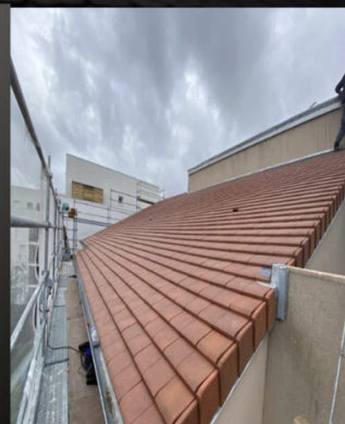
Marché de couverture pour IDF Habitat, réhabilitation complète des toitures et terrasses du 27-29 rue Salvador Allende à Bagneux, avec dépose et repose de tuiles, pose de pare-pluie, solins zinc et plomb, remplacement des gouttières et travaux d'étanchéité sur terrasses en site occupé.
