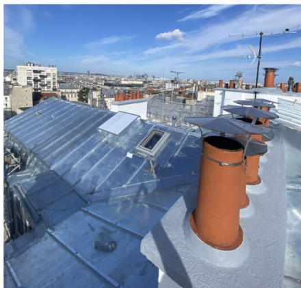
Marché de travaux d'entretien de la couverture pour Paris Habitat, réhabilitation de la couverture et de la verrière en toiture du 5 rue Hégésippe Moreau à Paris 18e, avec reprise d'étanchéité et sécurisation des ouvrages en parties hautes.
